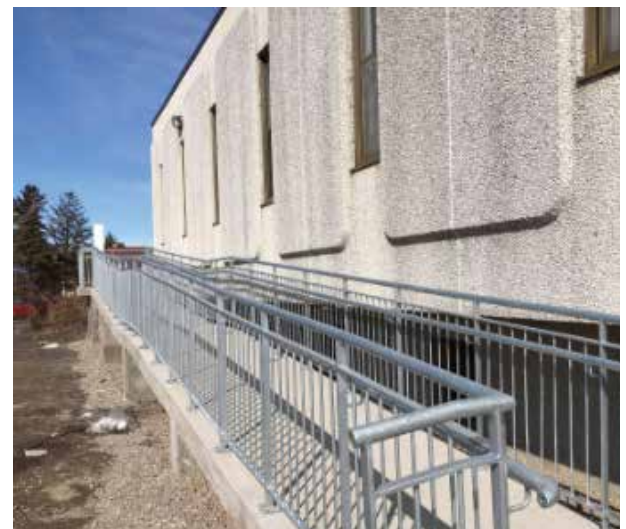
La nouvelle rampe d'accès universel au centre communautaire Daniel-Lafortune est maintenant installée!
